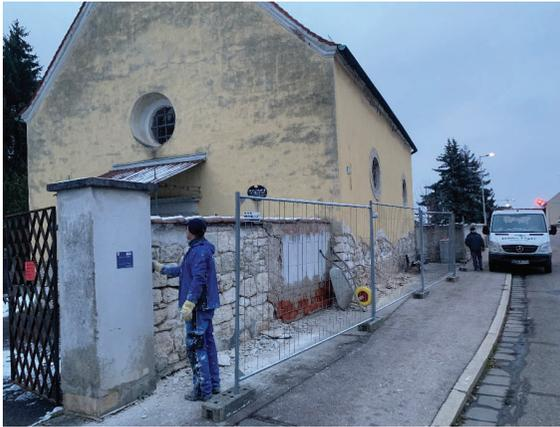
Die Notsicherungsmaßnahmen an der Sebastianskirche haben begonnen. Es wird der Dachraum von alten Dachziegeln und Schutt befreit, damit die Last auf dem Gewölbe geringer wird. Anschließend werden die kaputten Kehlbalcken der Dachkonstruktion durch spezielle Spanngurte ersetzt, damit die entstehenden Kräfte die Mauern nicht
