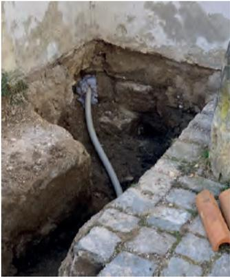
Inzwischen haben die Stadtwerke den neuen Hausanschluss für die Ottokapelle hergestellt. Künftig wird der Strom über die Wittelsbacher-gasse in die Kirche kommen und nicht mehr über den Dachständer des Spitals. Anschließend wird jetzt die Verkabelung im Innern auf den aktuellen Stand der Technik und des Brandschutzes gebracht werden.
